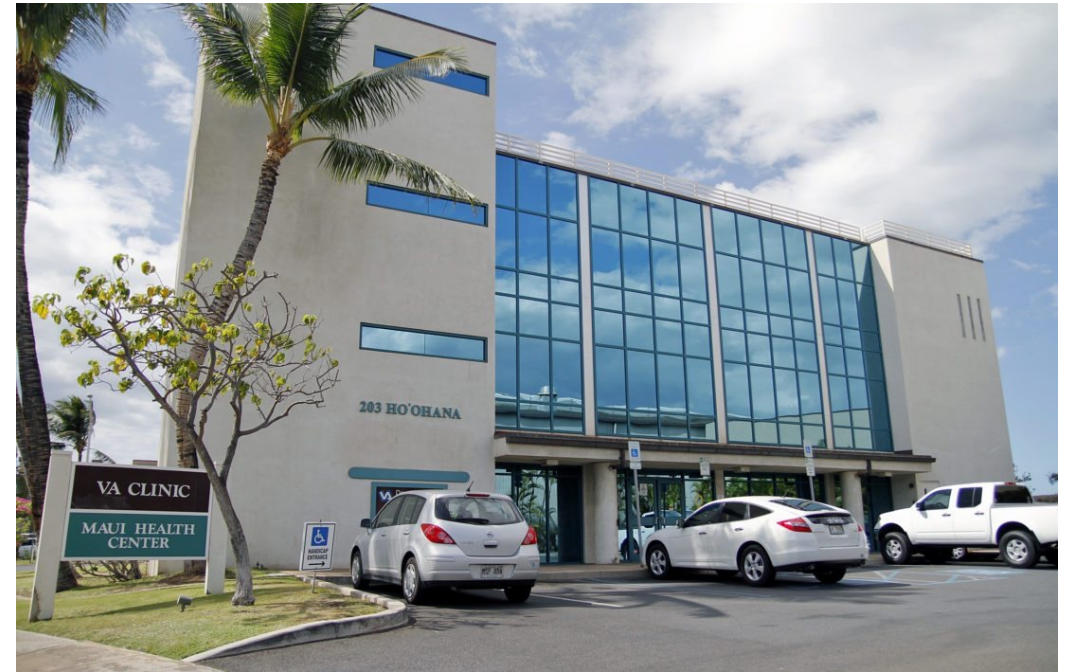
Existing Maui VA Clinic in Kahului
